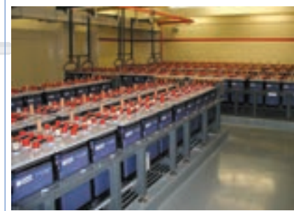
Рис. 13 Смонтированные батареи Classic GroE
