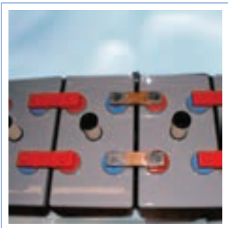
Рис. 5 Медные жесткие соединители под пайку
